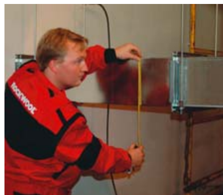
Obr. 2 – Proměření rozměrů potrubí
