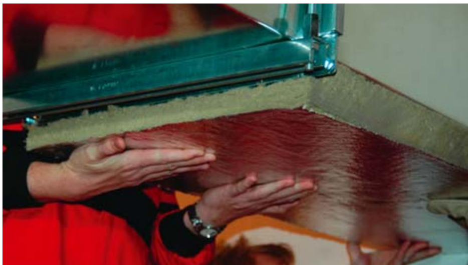
Obr. 3 – Přiložení desky na dno potrubí (následuje přikotvení)
