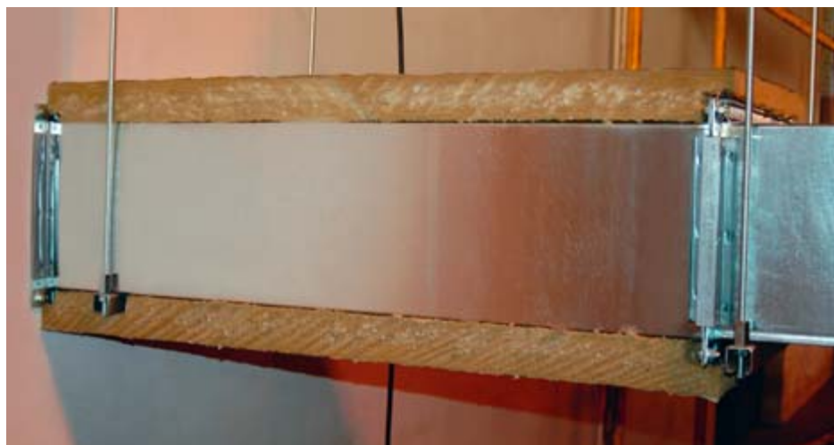
Obr. 4 – Deska je ukotvena přivařovacími trny (viditelné zářezy pro nosnou lištu hloubky 30 mm)
