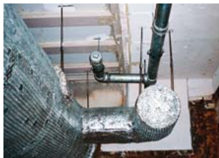
Obr. 8 – Příklad protipožárně izolovaného vzduchovodu s odbočkou - systém PYROROCK
