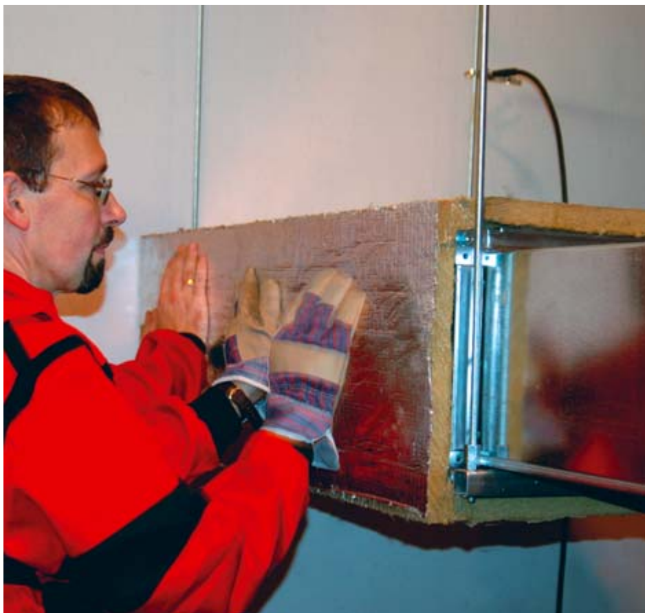
Obr. 1 – Montáž systému Conlit DUCTROCK
