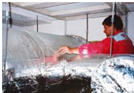
Obr. 7 – Dokončení povrchové úpravy šestihranným pletivem (platí pro potrubí DN ≥ Ø 500 mm)
