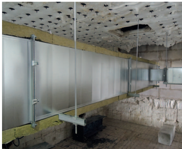
Obr. 27 Standardní jednovrstvé kladení izolace v místě přírub
