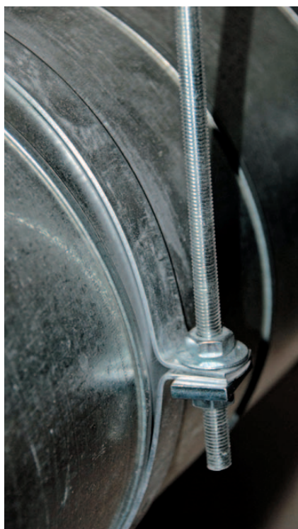
Obr. 33 Detail dvoudílné objímky pro zavěšení kruhového potrubí
