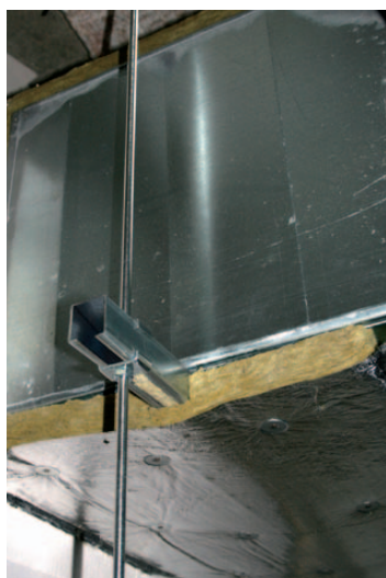
Obr. 28 Izolování instalačního profilu výšky 40 mm izolací tloušťky 40 mm
