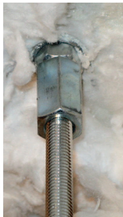
Obr. 34 Příklad kotvení závitové tyče do betonové stropní konstrukce pomocí ocelové hmoždinky
