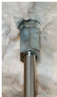
Obr. 60 Detail ocelové hmoždinky pro kotvení do betonové stropní konstrukce
