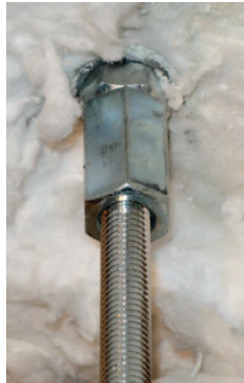
Obr. 20 Příklad kotvení závitové tyče do betonové stropní konstrukce pomocí ocelové hmoždinky
