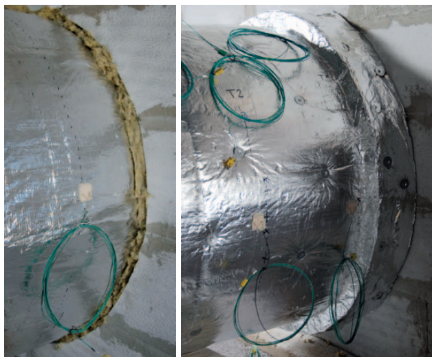
Obr. 37 Před provedením izolační manžety z druhé vrstvy lamelové rohože se nejdříve docpe meziprostor mezi izolovaným potrubím a požárně dělicí konstrukcí
