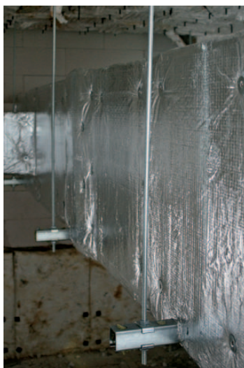
Obr. 29 Zavěšení potrubí závitovými tyčemi a instalačními profily. Na obrázku závitové tyče umístěny vně izolace (část instalačního profilu vyčnívajícího z izolace se v tomto případě neizoluje).
