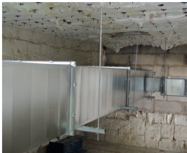
Obr. 27 Standardní jednovrstvé kladení izolace v místě přírub
